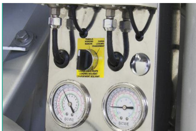
Manometri di alta e bassa pressione controllano il sistema di raffreddamento
