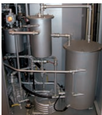
Evita la creazione di odori: separatore acqua "multistep"
